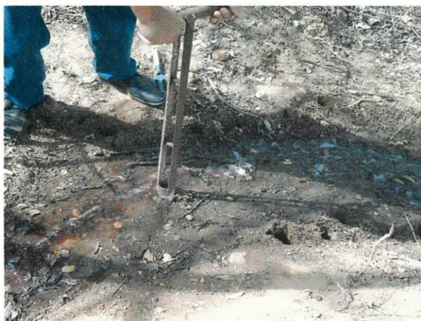
Figura 07: Saída do Esgoto (Ponto I)
