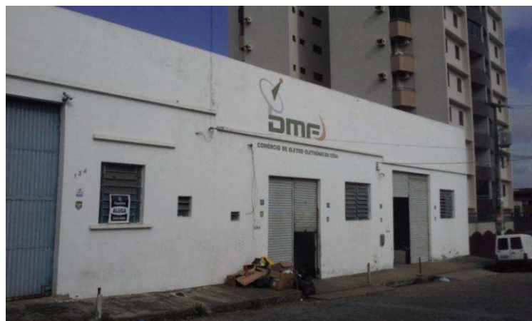
Figura 04: Antigo galpão da CATAMAIS
