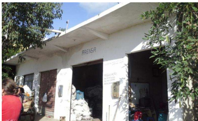
Figura 03: Galpão da ARENSA
