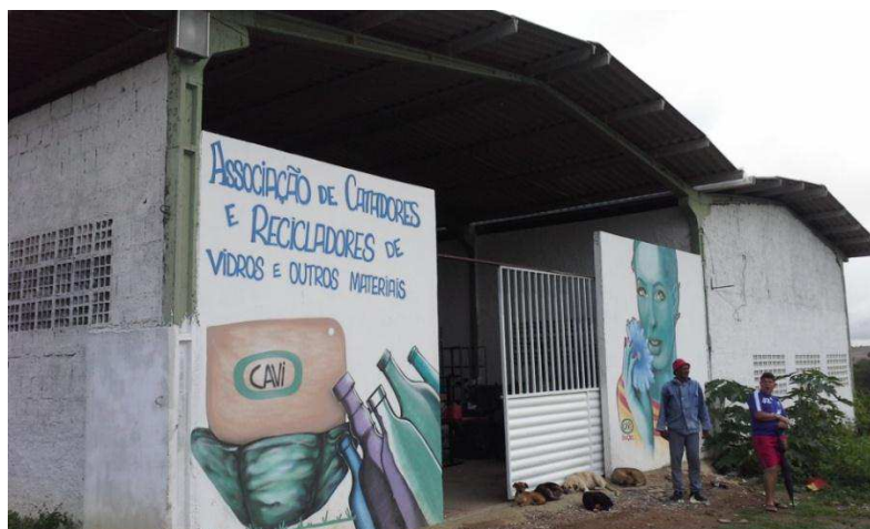
Figura 05: Galpão da CAVI
