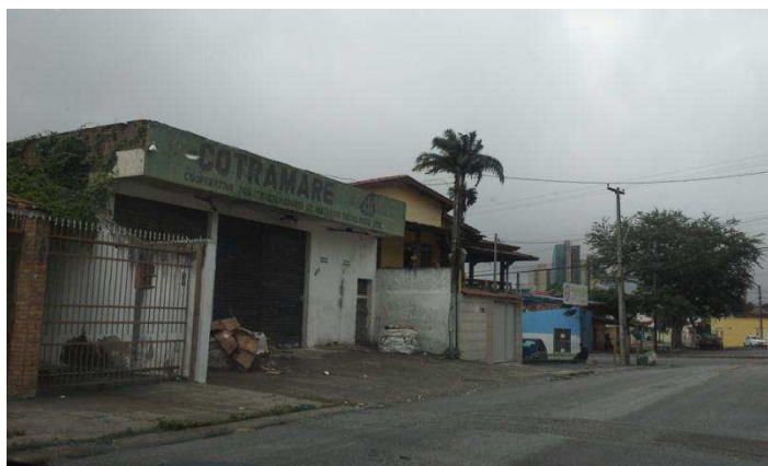
Figura 06: Galpão da COTRAMARE
