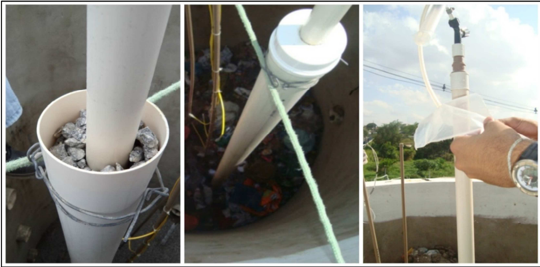
Figura 18 – Drenagem dos gases.
