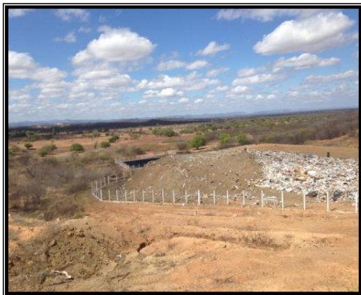
Figura 3 - Panorama do aterro sanitário Fonte: (SANTOS, ALMEIDA et al 2015)
