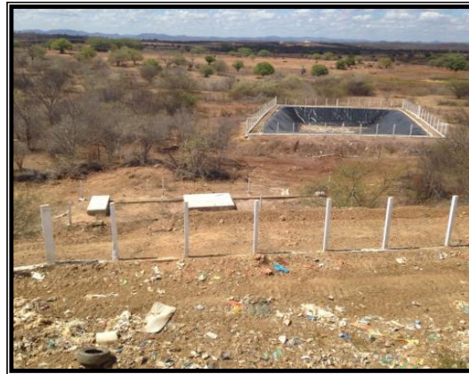
Figura 6 – Sistema de tratamento de líquidos percolados. Fonte: (SANTOS, ALMEIDA et al 2015)
