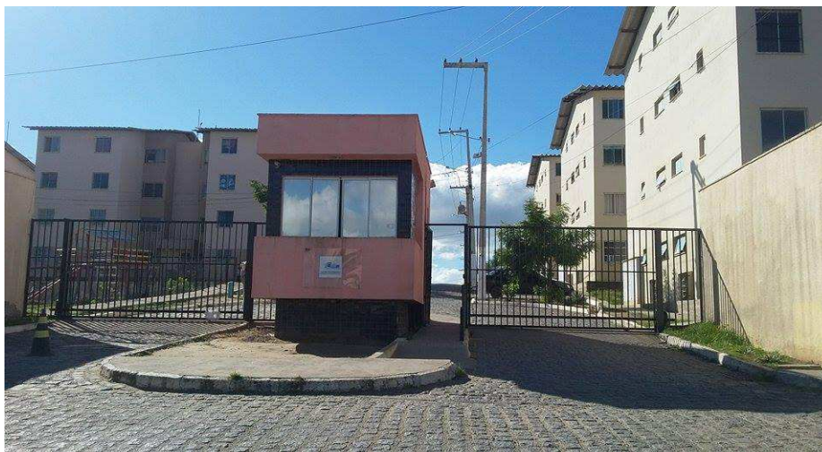
Imagem 5 - Condomínio Habitacional Major Veneziano - Faixada do Major II
