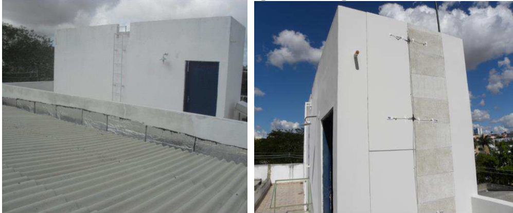
Figura 3.25. Imagem da parte externa da parede oeste (poente) da Célula de Teste.
