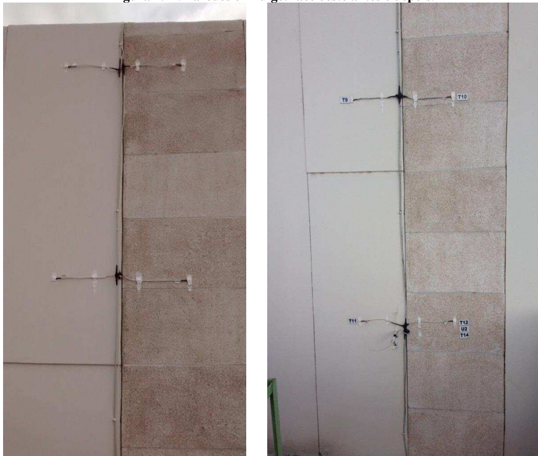
Figura 4.21. Paredes em fulget face oeste antes e depois.
