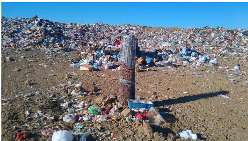
Fotografia 4 – Aterro Sanitário da Trash: sistema de drenagem de gases Fonte: Dados da Pesquisa (2016)
