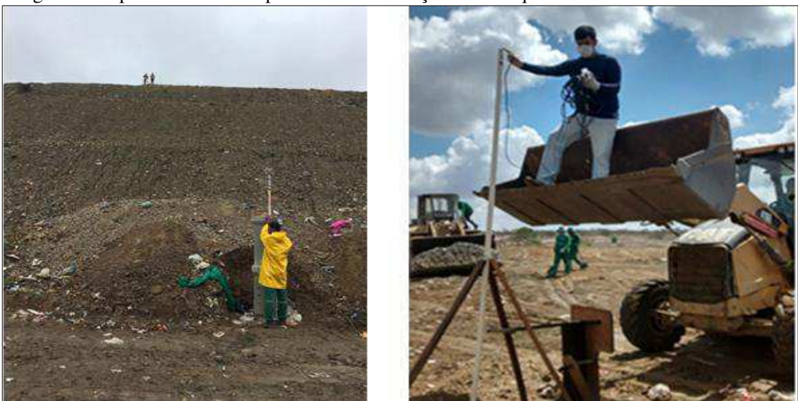
Figura 10: Operadores em campo realizando medição de recalques em aterro sanitário de RSU.
