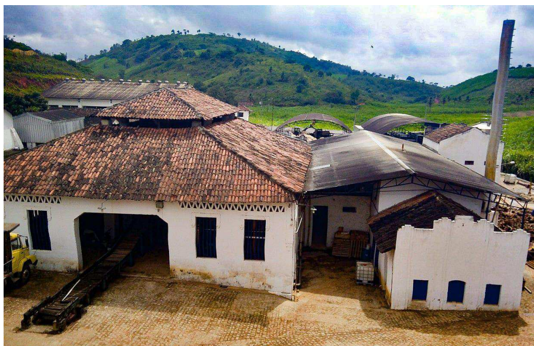
Figura 5 - Complexo edificado do Engenho Vaca Brava. Fonte: Autor (2020).
