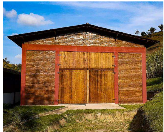
Figura 15 - Edificação com tijolo maciço. Fonte: Autor (2020).
