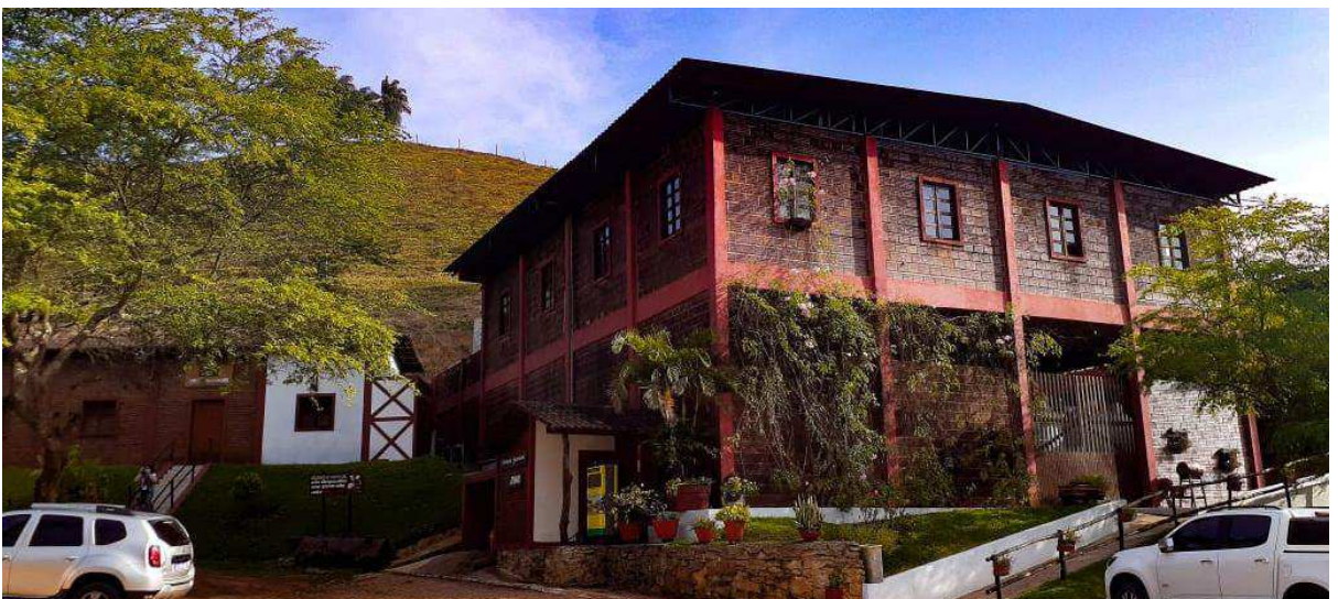
Figura 13 - Edificações agroindustriais do Engenho Triunfo. Fonte: Autor (2020).
