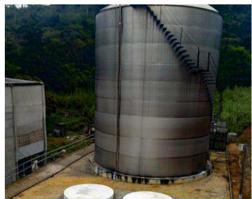
Figura 9 - Tanque em aço inoxidável. Fonte: Autor (2020).
