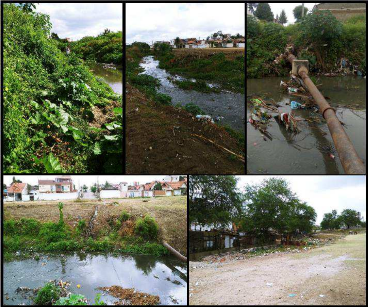
Figura 22 - Remoção da vegetação próxima aos canais de drenagem.
