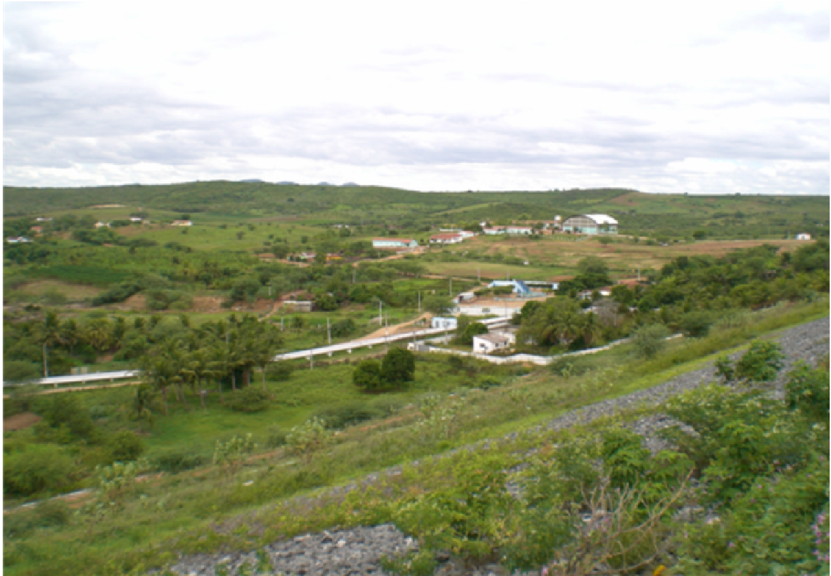
Foto 18 - A Adutora (2 tubulações) Fonte: Dados da pesquisa.
