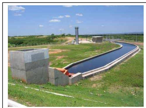
Foto 5 – Chegada do Canal ao perímetro
