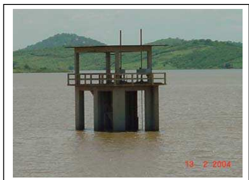
Foto 4 – Tomada D'água - reservatório Coremas
