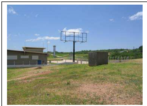
Foto 1 – Estação de bombeamento do perímetro irrigado Várzeas de Sousa
