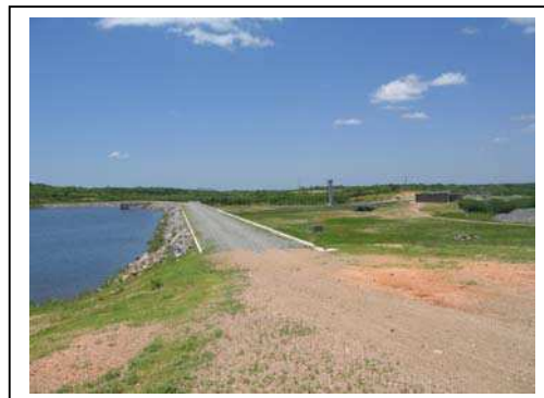
Foto 2 – Reservatório de acumulação
