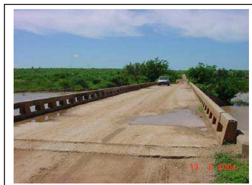
Foto 2 – Ponte sobre o Canal de ligação
