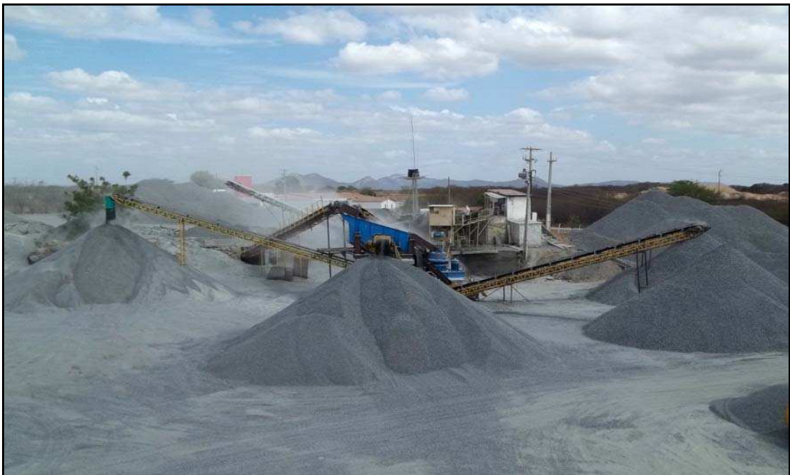
Figura 6 – Planta de britagem
