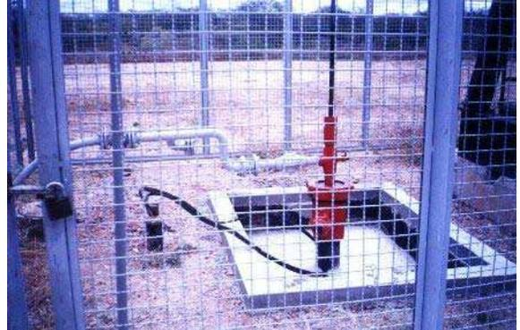
Figura 6.15 – Poço CAM - 197. Detalhe da estrutura de segurança do poço. Nota-se que o portão está trancado por um cadeado. A cisterna está limpa e a estrutura está bem conservada
