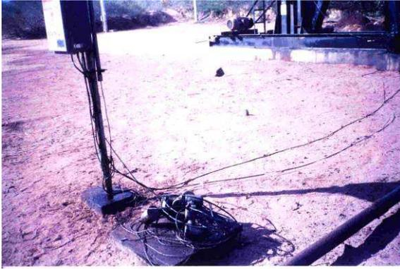
Figura 6.10 – O óleo jorrado atinge a instalação elétrica da estação automática de transmissão de dados
