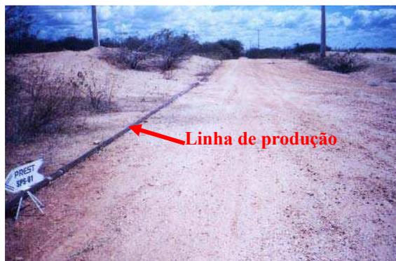
Figura 6.5 – Risco das linhas de produção depositadas diretamente sobre o solo. Ponto próximo ao poço CAM-490 (x = 699.207 ; y = 9.431.611)
