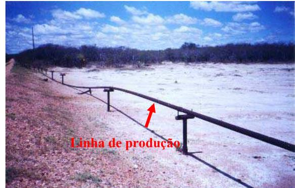
Figura 6.7 – Aspectos de deteriorização dos cavaletes de sustentação e duto em risco de corrosão pela água do mar
