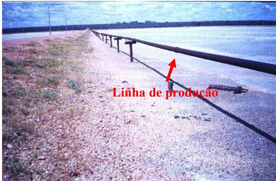
Figura 6.6 – Linha de produção do poço CAM-268. Deterioração dos cavaletes de ferro pela água do mar
