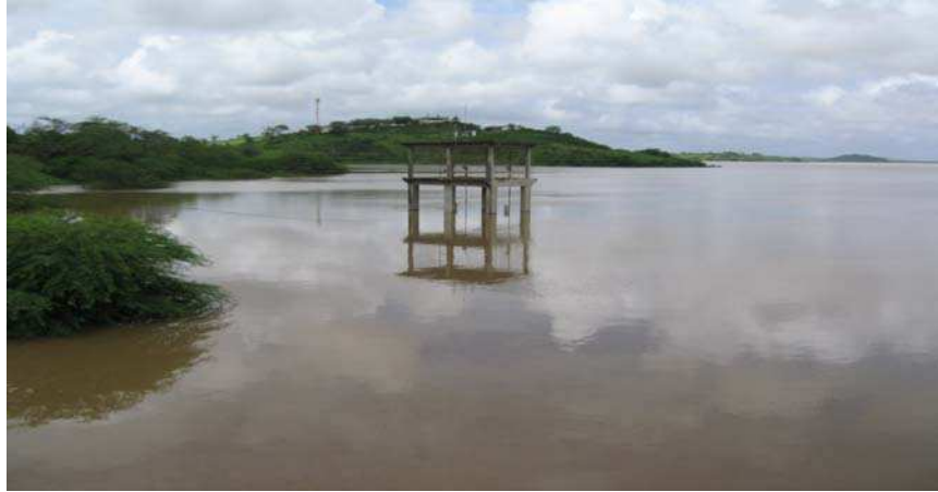
Figura 3.3 – Torre de captação na barragem de Boqueirão
