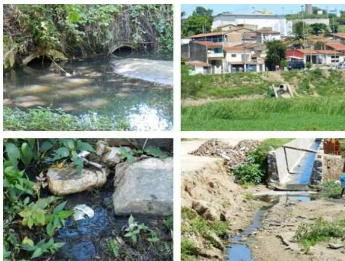
Figura 84 - Lançamento de esgoto bruto de bairros próximos direcionado para o açude sem qualquer tratamento prévio
