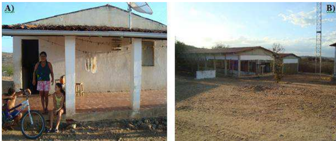
Figura 14: A) Residência localizada na Fazenda Escola. B) Galpões abandonados ao lado da residência. Coordenadas da Figura: 6° 25.334' S e 36° 22.129' W
