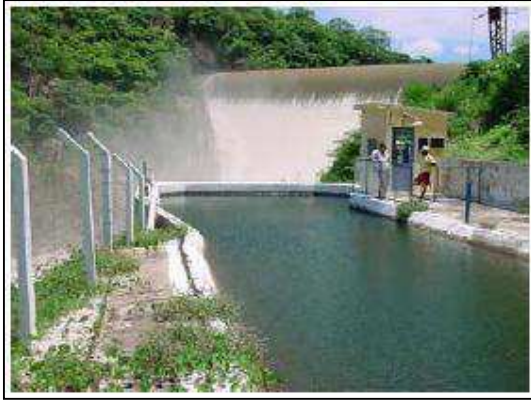
a) Saída do Canal da Redenção do açude Coremas
