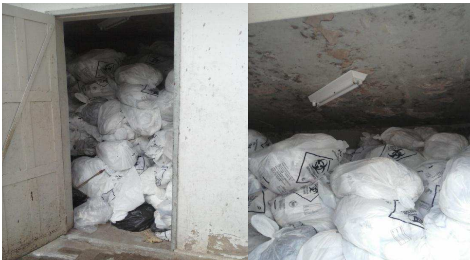
Figuras 27 e 28 – abrigo externo com sacos de RSS. Fonte: dados de campo.
