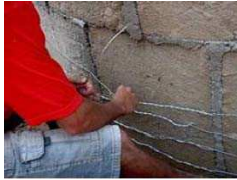
Figura 19 – Levantamento das paredes e amarração da parede externa com arame galvanizado.
