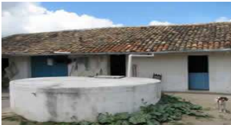
Figura 22 : Cisternas de placas pré-moldadas, modelo P1MC.
