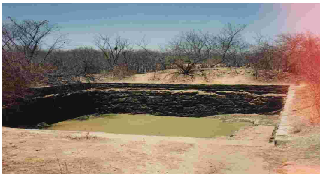
Figura 11 - Caxio criado para interceptar águas de enxurradas e armazená-las para consumo de animais e irrigações.
