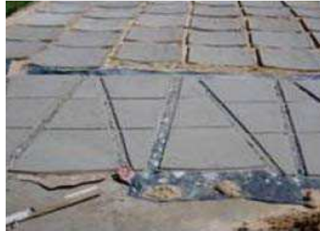
Figura 17 - Fabricação das placas da parede e do telhado da cisterna. Fonte - (a) e (b) SILVA (2006).
