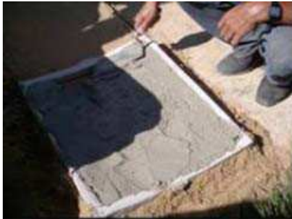
Figura 17 - Fabricação das placas da parede e do telhado da cisterna. Fonte - (a) e (b) SILVA (2006).
