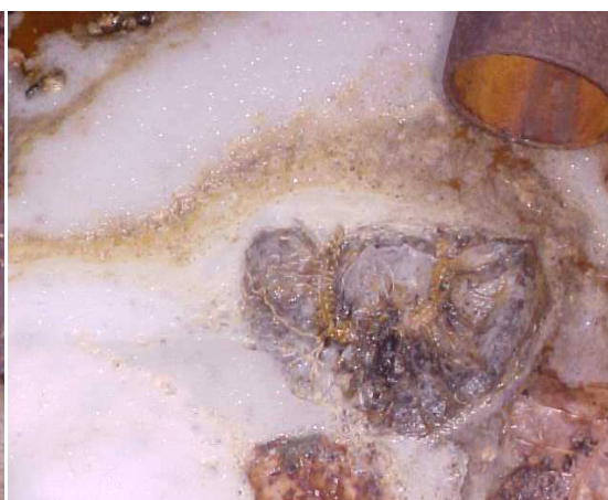
FIGURA 7.6 – Caixa de gordura
