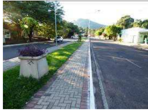
Figuras 106 – Canalização fechada do Córrego Monjolo Fonte: Foto da autora (2015).
