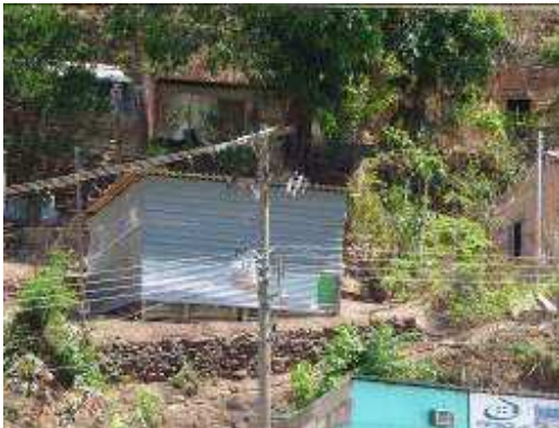
Figura 52 – Edificação com materiais improvisados Fonte: Foto da autora (2015).
