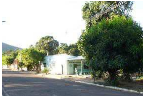
Figuras 110 – Edificações comerciais na APP do Córrego Avoadeira II, trecho próximo à foz. Fonte: Foto da autora (2015).
