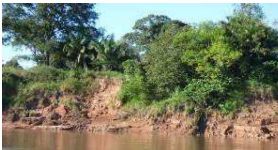
Figura 79 – Erosão na margem esquerda do trecho 03 do rio das Garças Fonte: Foto da autora (2015).
