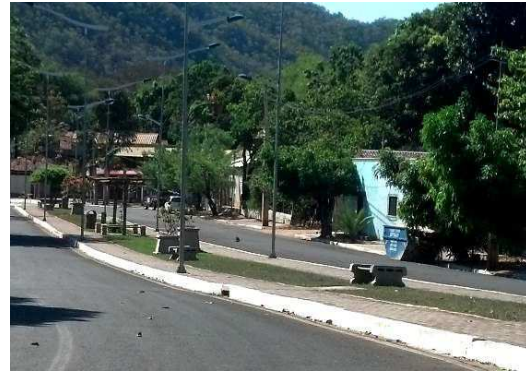
Figura 13 – Córrego Monjolo canalizado, Barra do Garças – MT Fonte: Foto da autora (2015).
