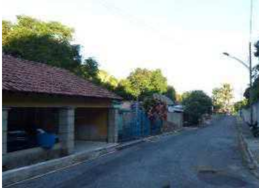
Figuras 109 – Edificações residenciais na APP do córrego Avoadeira II. Fonte: Foto da autora (2015).
