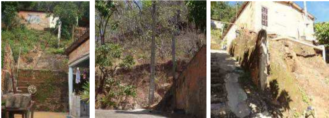
Figura 49 – Lote com alto declive propenso a deslizamentos Figura 50 – Terreno com feições indicativas de movimentação de massa Figura 51 – Residência em terreno bastante inclinado Fonte: Fotos da autora (2015).
