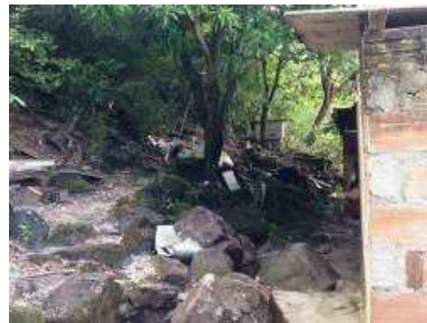
Figura 48 – Blocos rochosos desprendidos no bairro Santa Rosa. Fonte: Foto da autora (2015).
