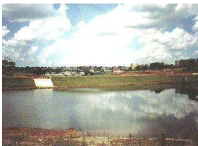
Figura 9 – Bacia de retenção Fonte: Canholi (2005).
