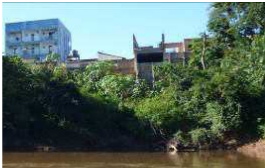
Figura 86a – Edificação em construção no trecho 04 margem esquerda. Imagem normal Fonte: Foto da autora (2015).
