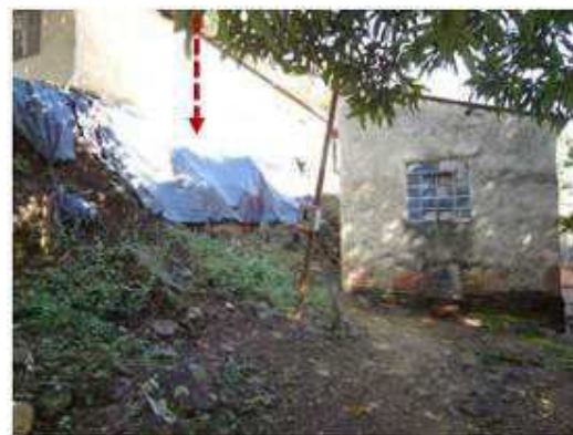
Figura 53 – Método de contenção improvisado Fonte: Colturato (2013).
