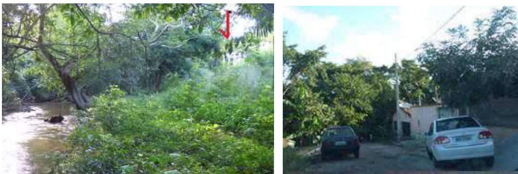
Figura 104a e 104b – Edificação em APP a jusante do Córrego Fundo I. Fonte: Foto da autora (2015).
