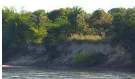
Figura 78 – Erosão no trecho 03 margem esquerda do rio das Garças Fonte: Foto da autora (2015).
