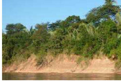
Figura 82 – Erosão na margem direita do trecho 04 do rio das Garças Fonte: Foto da autora (2015).
