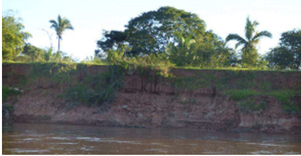
Figura 81 – Erosão na margem direita do trecho 04 do rio das Garças Fonte: Foto da autora (2015).
