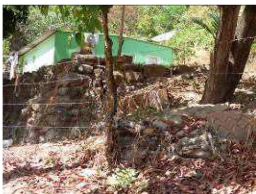
Figura 43 – Enrocamento de terreno na encosta da Serra Azul Fonte: Foto da autora (2015).
