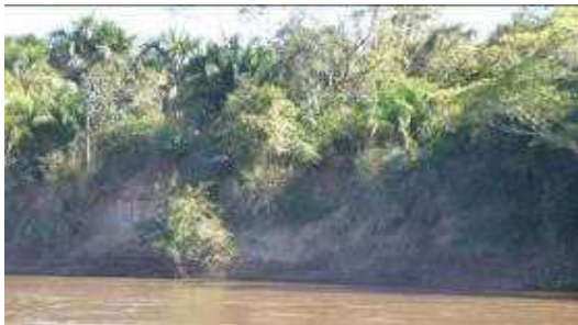
Figura 91 – Erosão na margem esquerda do trecho 02 – Rio Araguaia.
