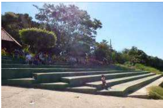
Figuras 95c – Porto do Baé nas margens do rio Araguaia. Fonte: Foto da autora (2015).
