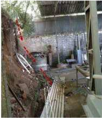
Figura 45 – Movimento de terra ao fundo de uma edificação comercial Fonte: Colturato (2013).
