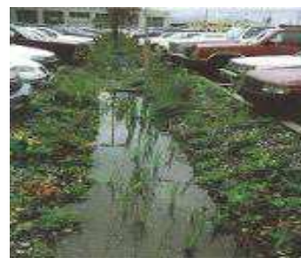
Figura 10 – Valeta de infiltração Fonte: Canholi (2005).
