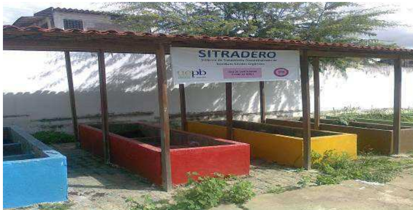
Figura 13 – Foto do Sistema de Tratamento Descentralizado de Resíduos Sólidos Orgânicos Domiciliares implantado no bairro de Santa Rosa, Campina Grande – PB, 2012.
