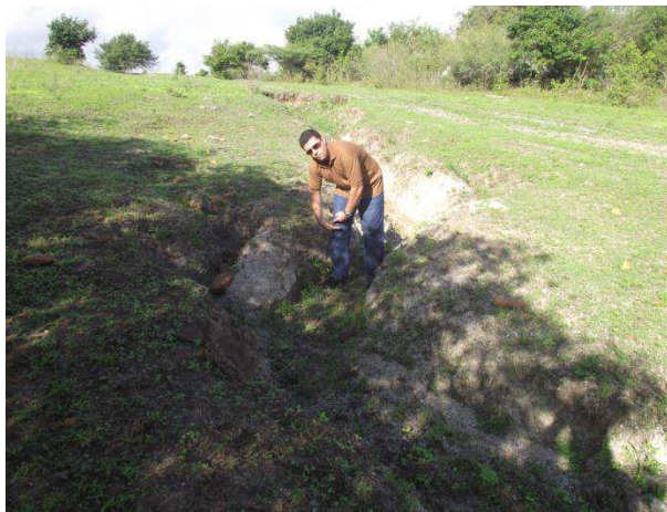
Figura 44. Erosão no Complexo Aluízio Campos, 2013
