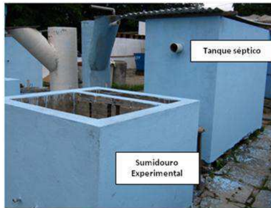
Figura 3.4 - Tanque séptico seguido de sumidouro experimental SUM1
