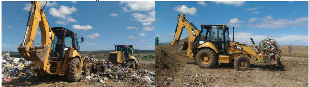
(a) homogeneização dos resíduos na frente de operação da célula
