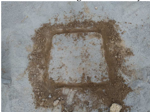
(a) demarcação do perímetro da placa e escavação da vala
