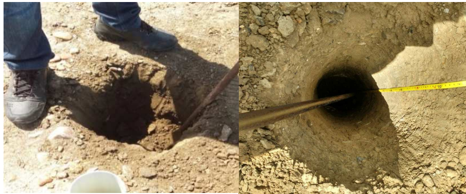
Figura 30. Instalação de dispositivo de medição de concentração de gases (DMC) na interface solo-resíduo
