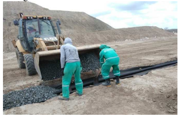
(b) preparação das valas de coleta e escoamento do lixiviado
