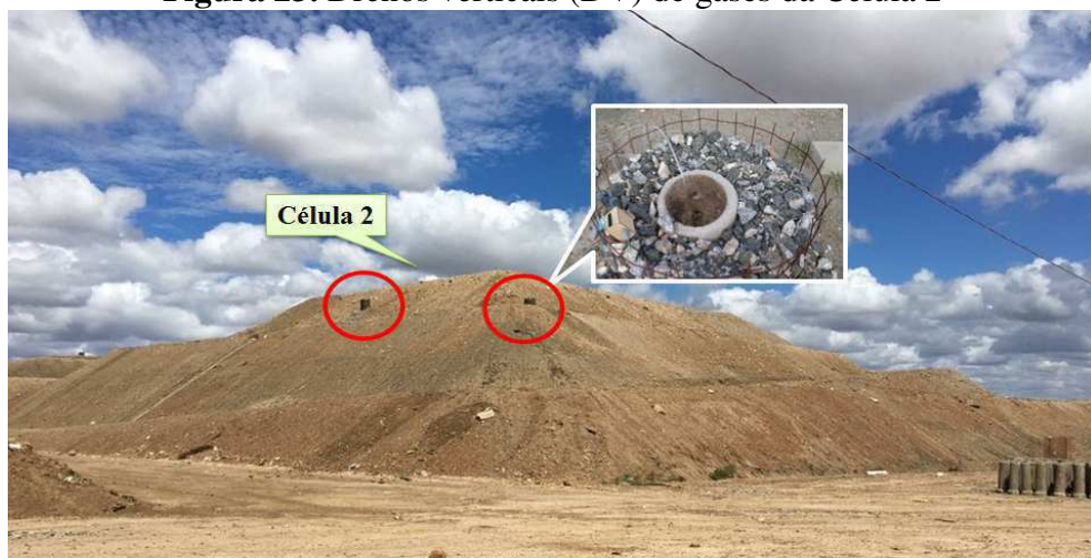
Figura 23. Drenos verticais (DV) de gases da Célula 2
