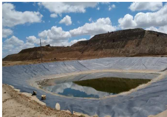
(c) Lagoa de Tratamento de Lixiviado
