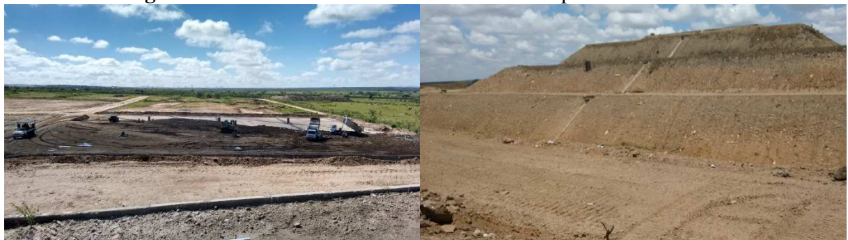
Figura 22. Célula 2 do Aterro Sanitário em Campina Grande-PB
