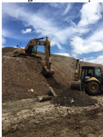
(a) abertura de vala
