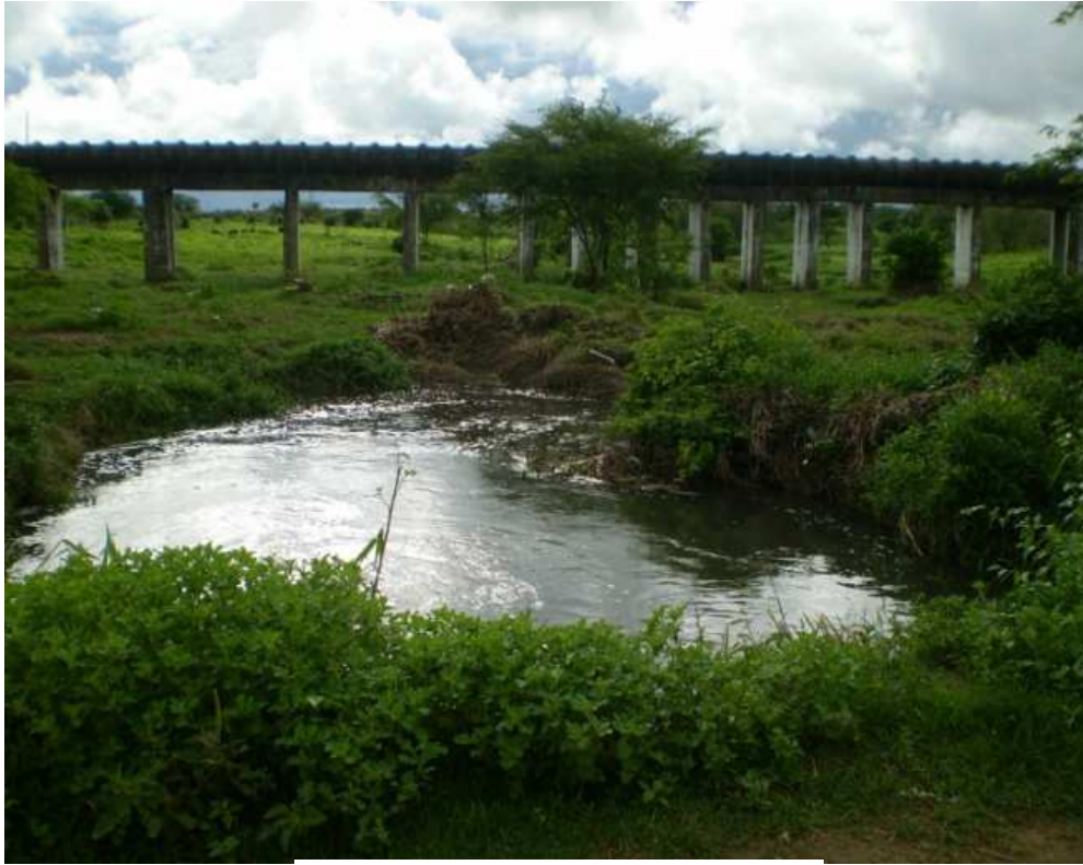
Figura 5.5: Arredores das Lagoas de Estabilização da CAGEPA
