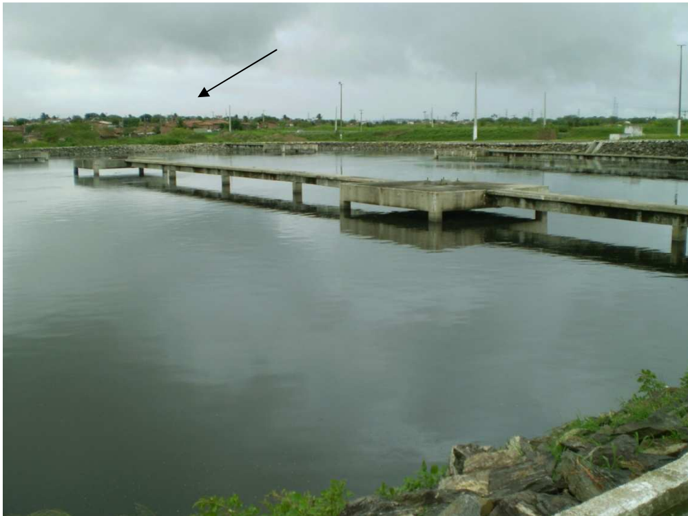
Figura 5.6: Proximidade das residências com as Lagoas de Estabilização
