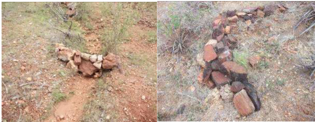
Figuras 15a e 15 b – Barramentos para contenção do processo erosivo
