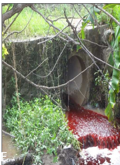
Figura E - Lançamentos de efluentes Industriais no córrego da comunidade Mumbaba.
