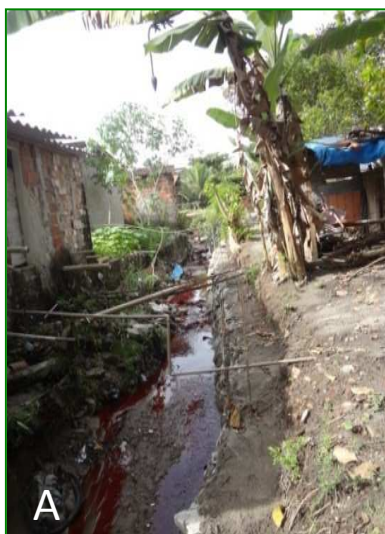
Figura A - Lançamento de esgoto doméstico e industrial a céu aberto (Mumbaba).
