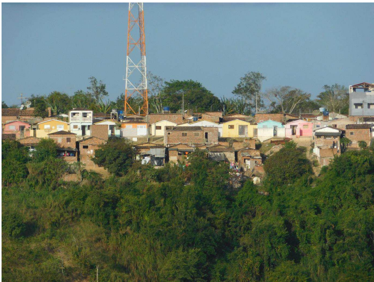
Fotografia 1 – Ocupação em área de risco de deslizamento na rua Panorâmica.
