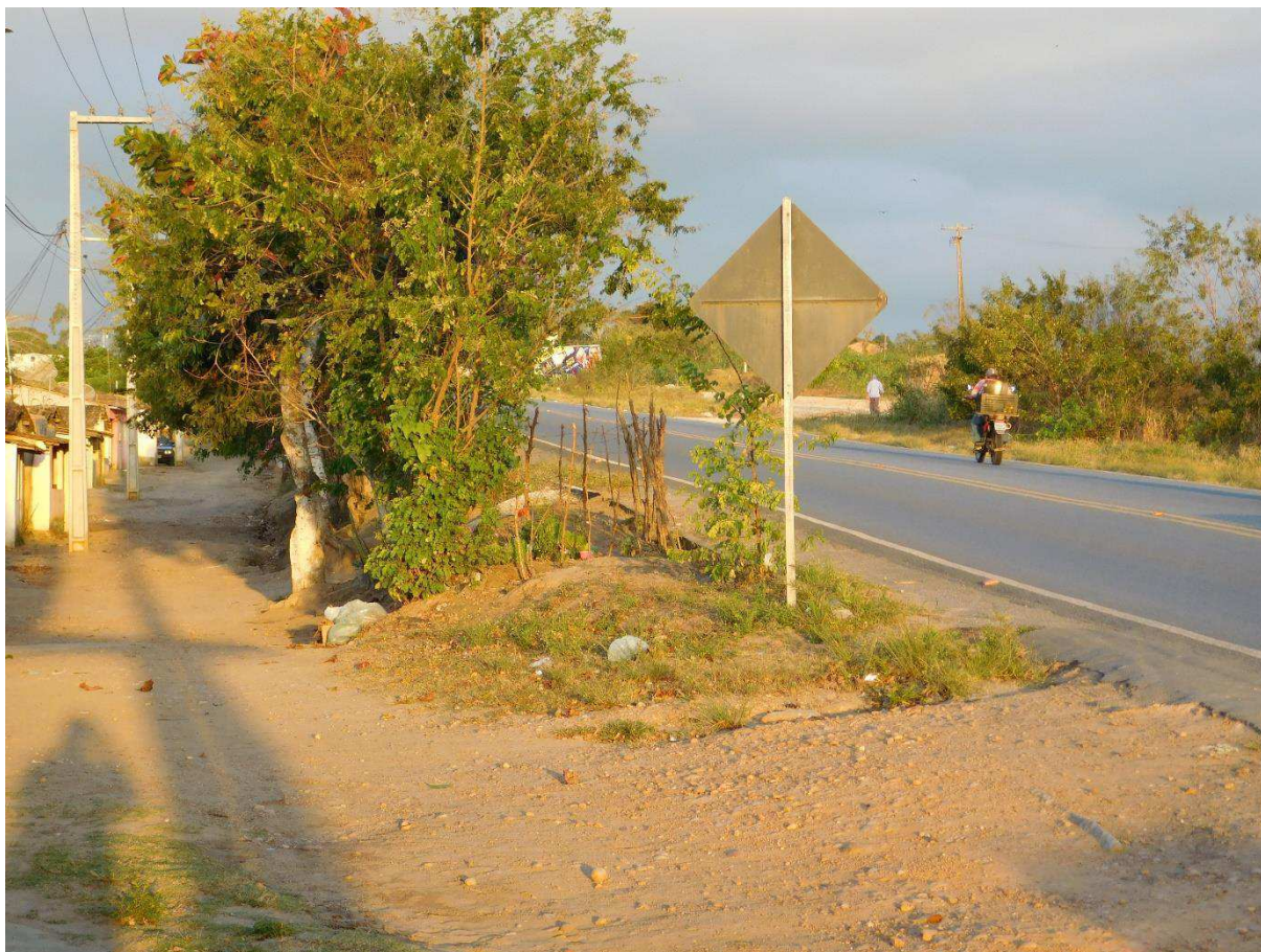
Fotografia 3 – Ocupação em área de risco de alagamento na comunidade do Piçarro.
