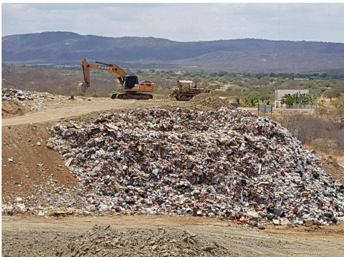
**Figura 6.** Espalhamento, compactação, aterramento e cobertura dos RS no Aterro sanitário de Sousa.
