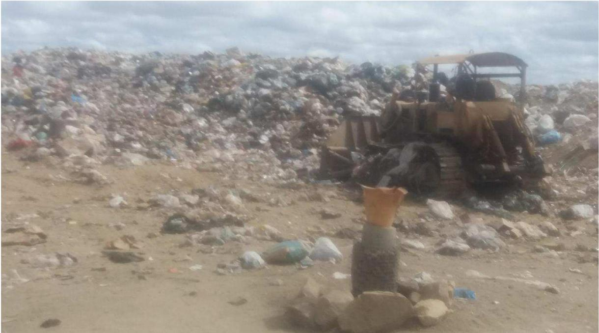
**Figura 8.** Sistema de drenagem de gases do Aterro sanitário de Sousa.
