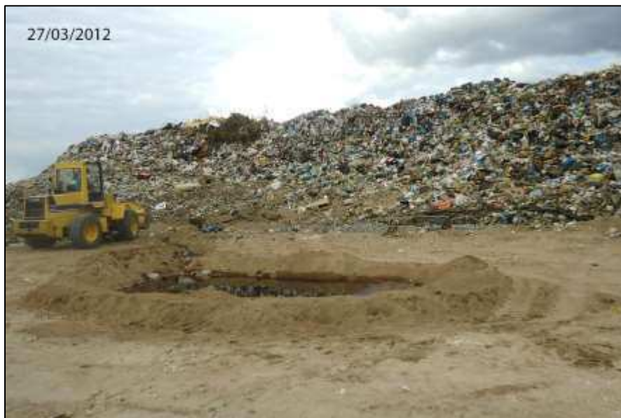
Figura 96: presença de chorume acumulado em poças próximo ao local de disposição dos resíduos. Fonte: Paraíba (2012b).
