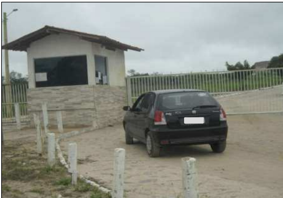
Figura 90: Entrada do aterro sanitário da construtora planície, localizado na zona rural de Puxinanã. Fonte: Pesquisa de campo.
