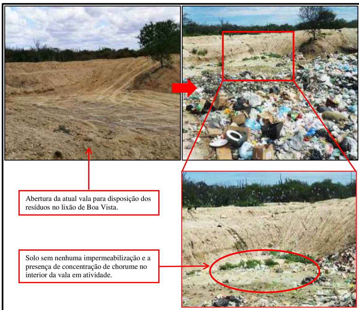
Figura 43: Condições atuais do lixão municipal de Boa Vista, com destaque para o acúmulo de lixiviado no solo. Fonte: Pesquisa de campo.
