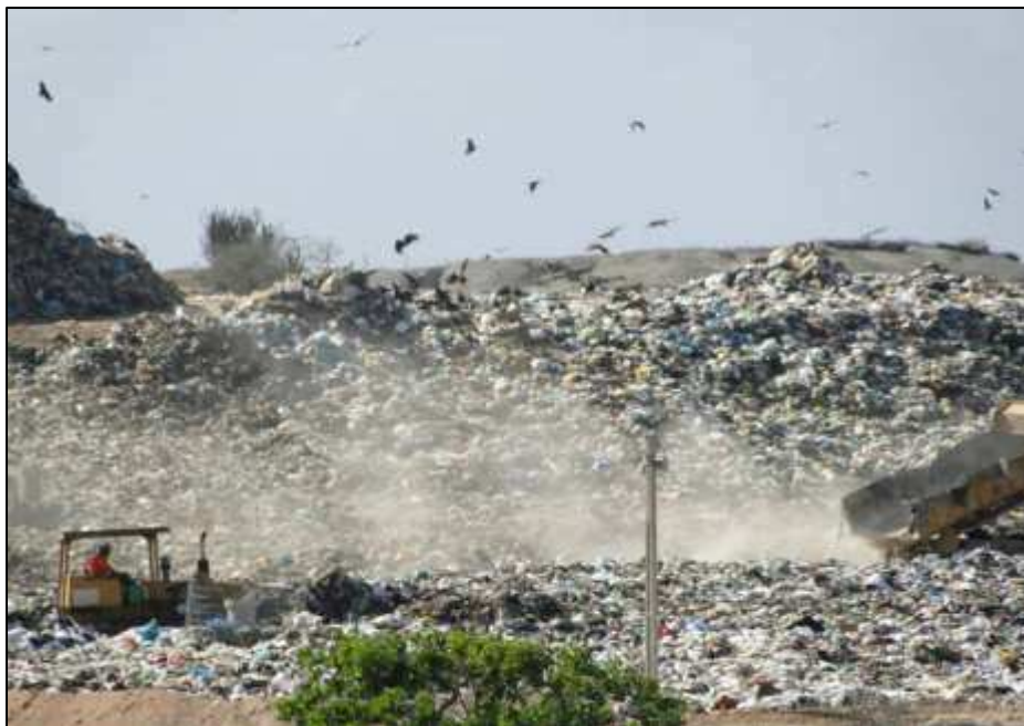
Figura 99: presença de urubus na instalação do aterro sanitário. Fonte: Costa (2013b).
