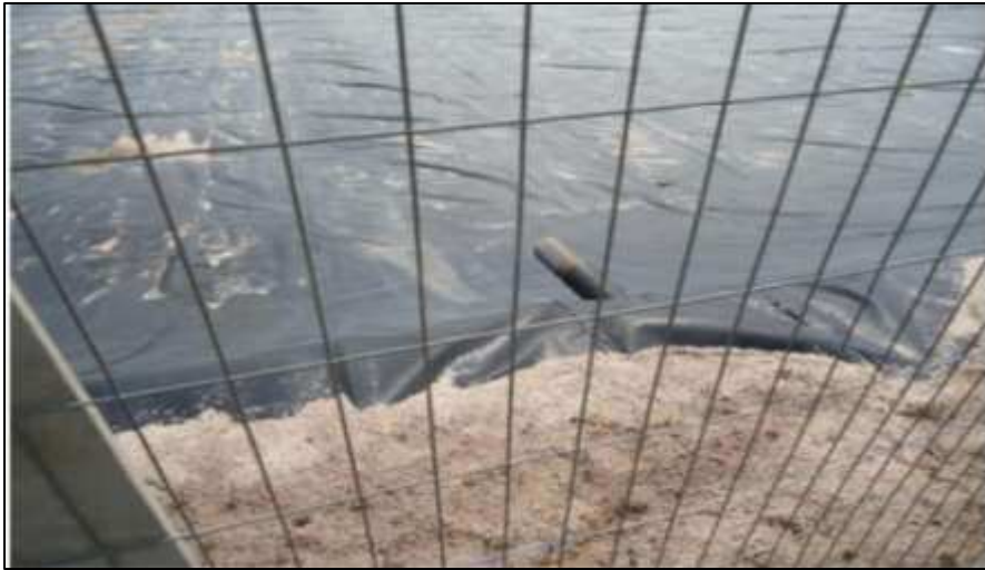
Figura 95: Estação de Tratamento de Efluente para onde o chorume deveria estar sendo escoado. Fonte: Paraíba (2012b).
