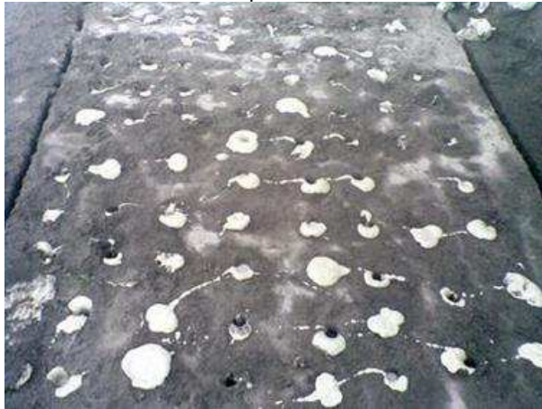
Figura 8: Furos preenchidos com argamassa expansiva
