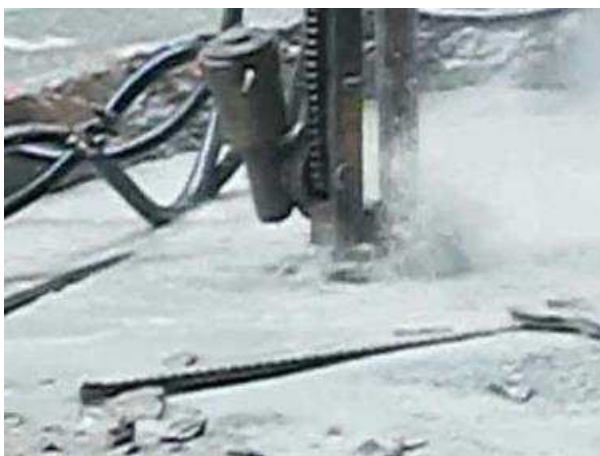
Figura 14: Perfuração de rocha com geração de pó (resíduo)
