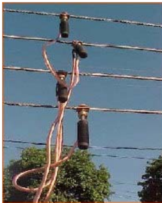
Figura 19 - Aterramento temporário em rede de baixa tensão
