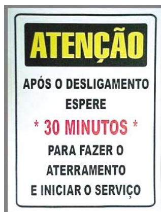
Figura 37 – Placa: atenção para banco de capacitores e cabos a óleo
