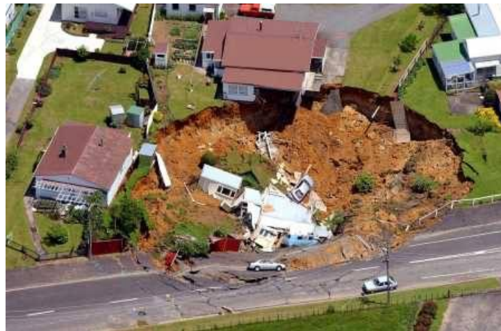
Figura 10 – Fotos de subsidência ocorrida em dezembro de 2005 em Vazante M.G
