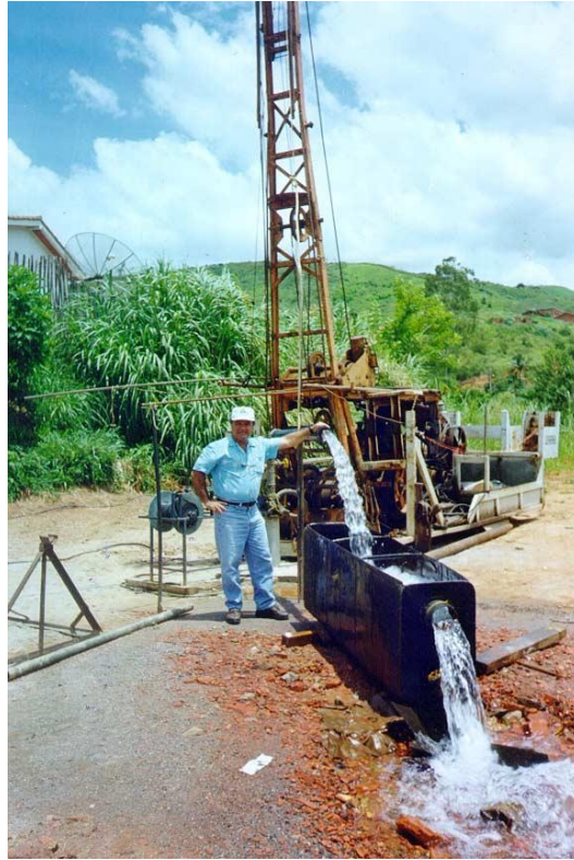
Figura 8 - Teste de bombeamento em poço perfurado em cristalino
