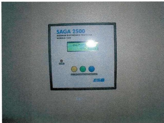
Figura 02 – Medidor Digital tipo SAGA 2500.
