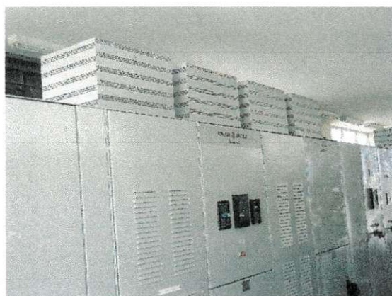
Fig A5 - Resistores de desexcitação dos motores síncronos.
