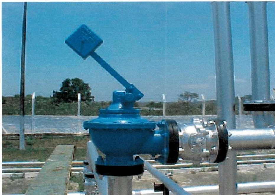
Figura 13: Válvula de peso
