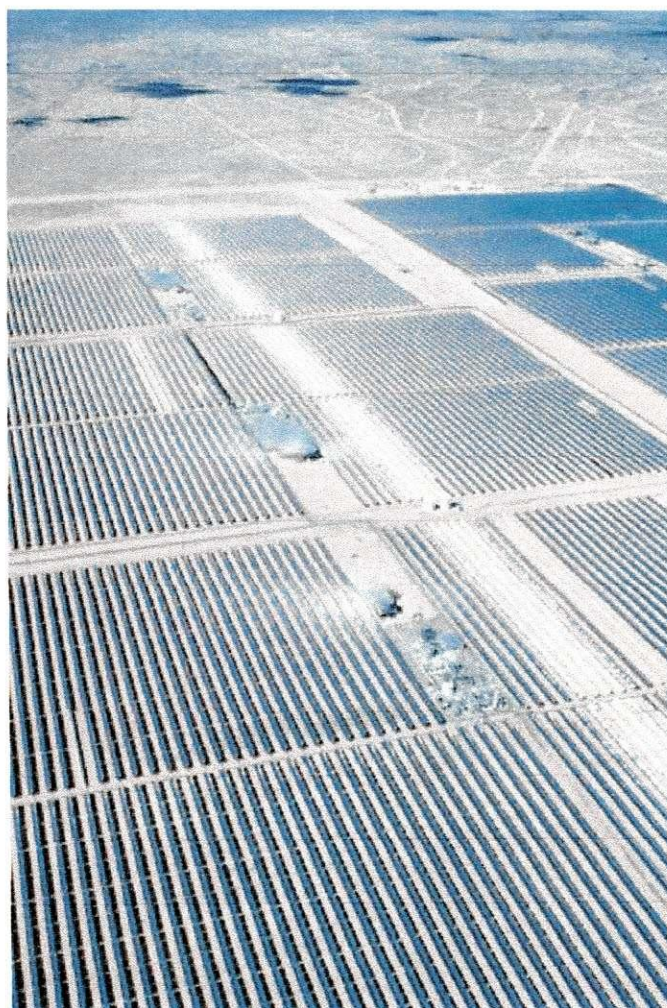
Figura 2.3 – campos de coletores concentradores de 8MW cada um, localizados no Deserto de Mojave, Califórnia, operacionais desde 1989 Fonte: DLR-PSA
