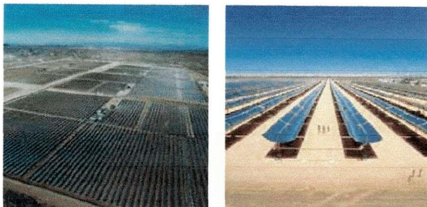
Figura 3.4 - Central com Concentradores "Trough" na Califórnia Fonte: KJCOC
