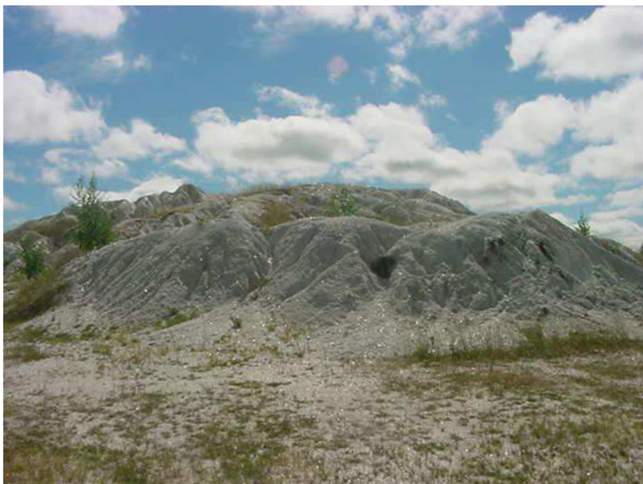
**Figura 3.2** - Vista da área utilizada para deposição do resíduo gerado durante o processo de beneficiamento do caulim (Empresa Caulisa - Município de Juazeirinho – PB)
