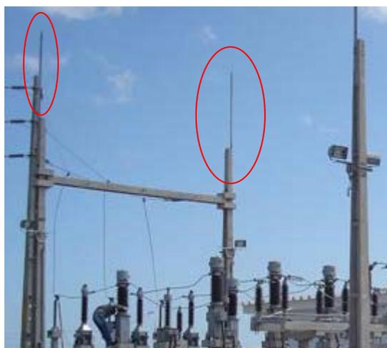
Figura 5.2 – Mastro para a proteção contra descargas atmosféricas (retirado de [www.weg.net](http://www.weg.net)).
