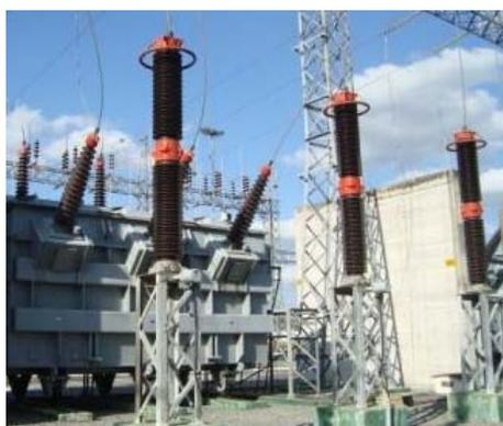
Figura 7.3 – Pára-raios conectado a um dos transformadores da SE Campina Grade II – Chesf
