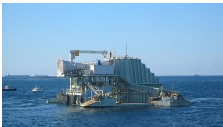
Fig. 3.6: Usina OWC nearshore de 1.5 MW localizada na Austrália
