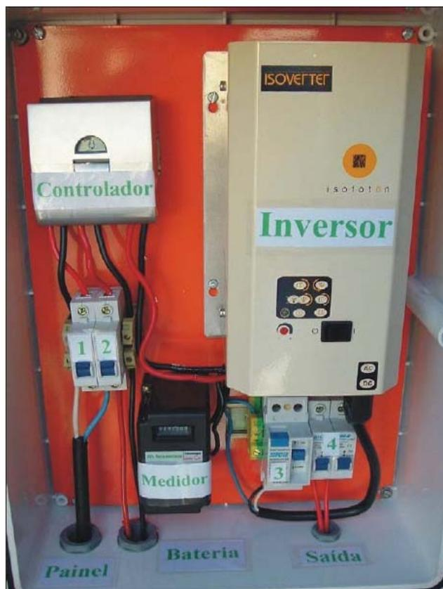
Fig.21 - Quadro Geral de um Sistema Fotovoltaico
