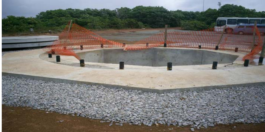
Figura 12 – Exemplo do Tipo de Fundação para Aerogerador.
