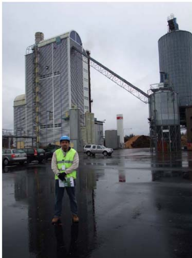
Figura 5.2 - Instalação da Planta de Gaseificação de Värnamo na Suécia, (Cenbio, 2001).
