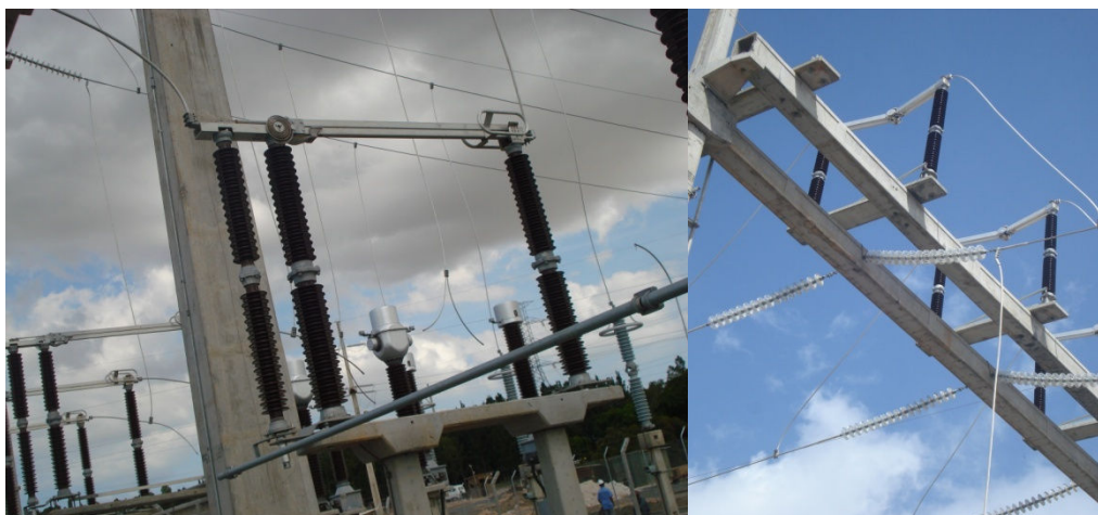
Figura 4.5 – Chaves seccionadoras terrestres e de by pass – SE UTE Muricy I
