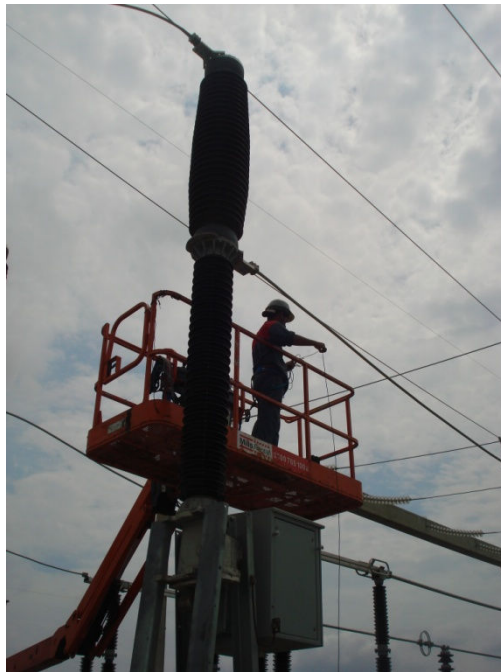
Figura 4.6 – Disjuntores a SF 6 - SE UTE Muricy I
