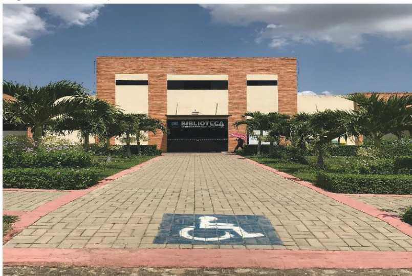
Figura 16 – Rampa de Acesso em Frente à Biblioteca do CES.
