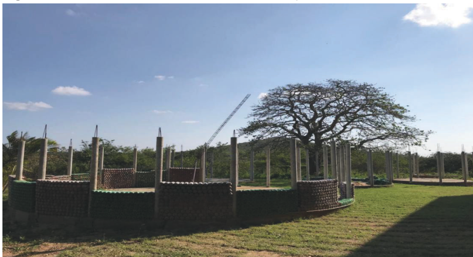
Figura 22 – Obra Sustentável do CES em Construção.
