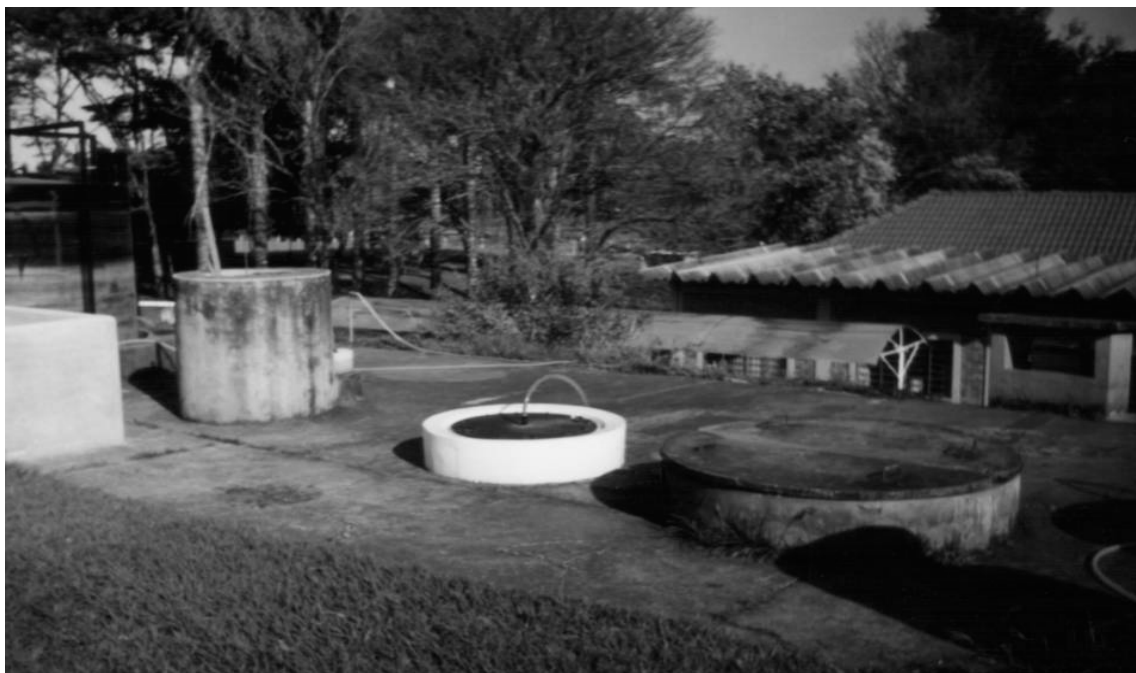
FIGURA 13: BIODIGESTOR CONTÍNUO MODELO CHINÊS
