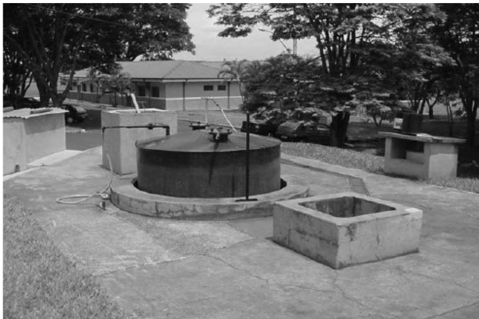
FIGURA 10: IMAGEM DE UM BIODIGESTOR DO TIPO INDIANO INSTALADO
