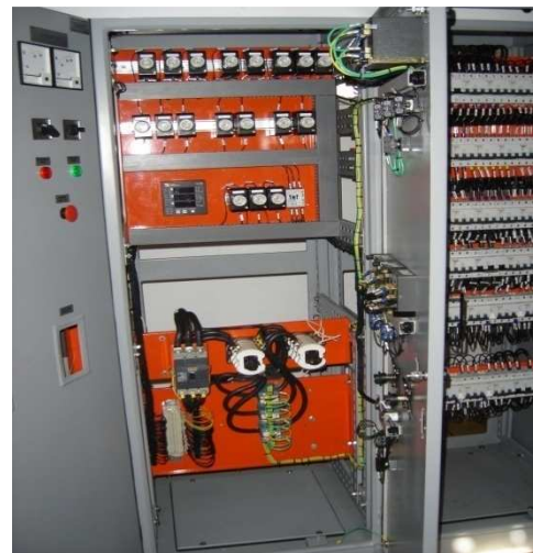
Figuras 3.1.2.2.31 - Vista Interna Painel Elétrico (Proteção e Medição) Rebocador Jatobá
