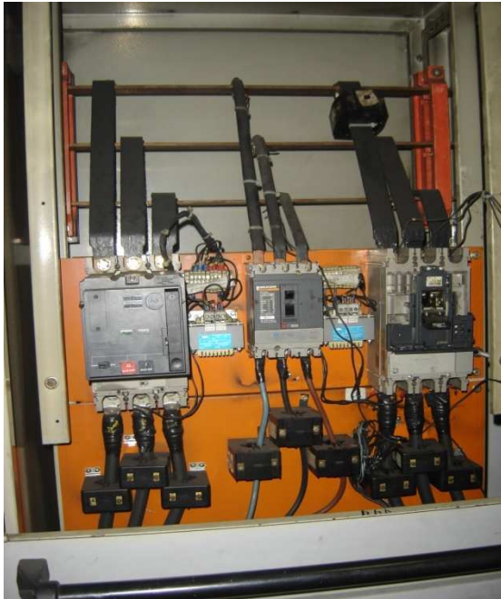
Figura 3.1.2.2.23 - Vista Interna Painel de Proteção Figura 3.1.2.2.24 – Vista Externa P. de Prot.
