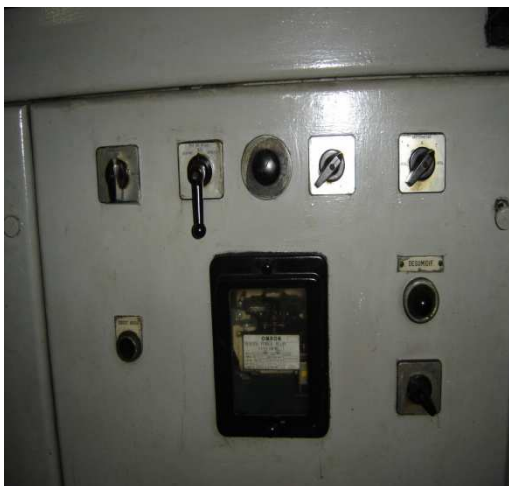
Figura 3.1.2.2.6 - Vista Ext. P. Relé de Pot. Reversa
