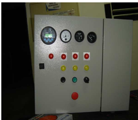
Figura 3.1.2.2.19- Painel de Controle de Motor Vista Externa Figura 3.1.2.2.20- Painel de Controle de Motor Vista Interna
