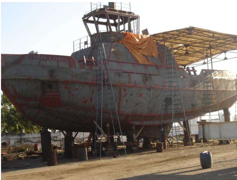
Figura 3.1.2.2.29 - Rebocador Jatobá em construção
