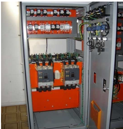
Figuras 3.1.2.2.31 - Vista Interna Painel Elétrico (Proteção e Medição) Rebocador Jatobá
