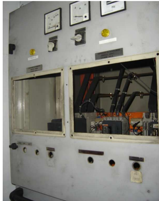
Figura 3.1.2.2.23 - Vista Interna Painel de Proteção Figura 3.1.2.2.24 – Vista Externa P. de Prot.
