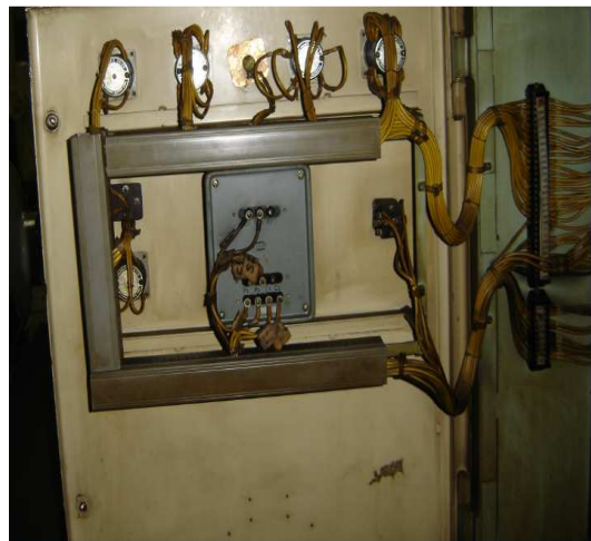
Figura 3.1.2.2.7- Vista Int. P.l Relé de Pot. Reversa
