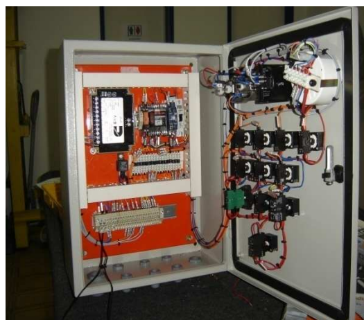
Figura 3.1.2.2.19- Painel de Controle de Motor Vista Externa Figura 3.1.2.2.20- Painel de Controle de Motor Vista Interna
