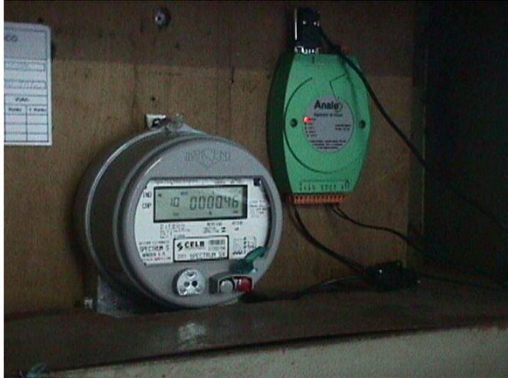
**Figura 22 - Registrador de Pulsos instalado.**
